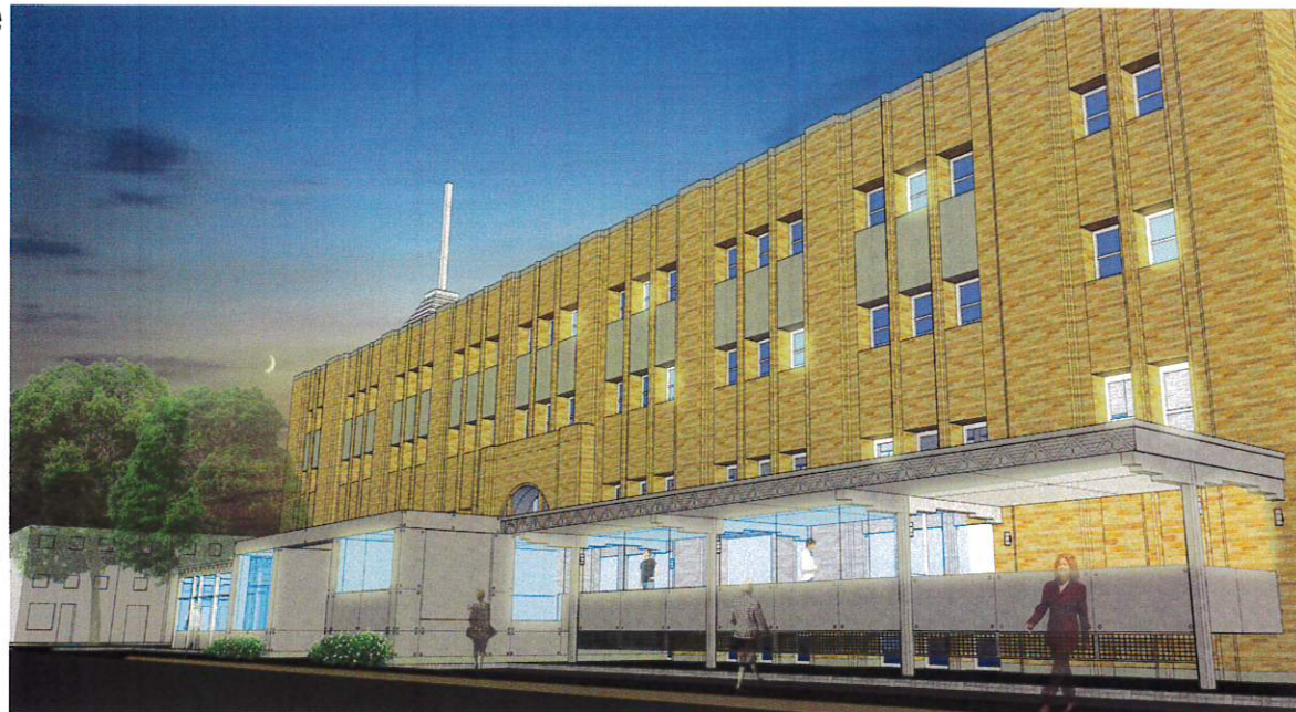
Vue d'ensemble de la rue Wolfe
