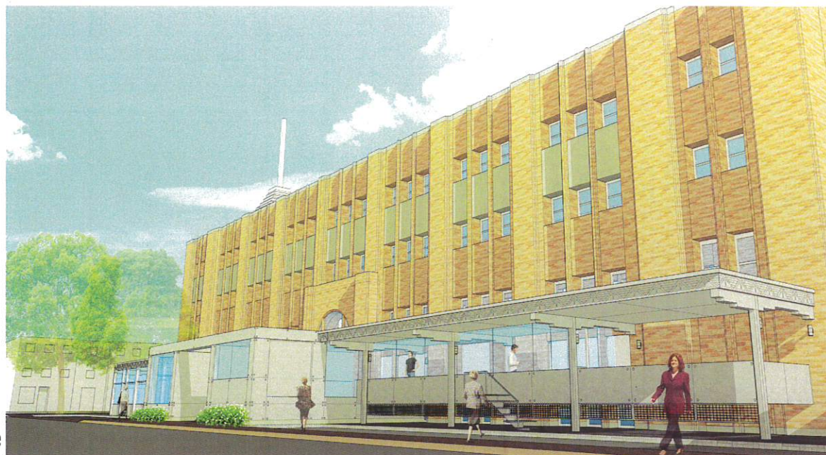
Vue d'ensemble de la rue Wolfe
