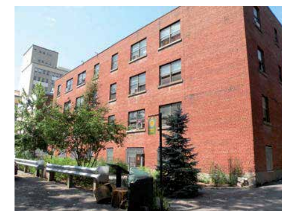
9. Immeuble à logement à l'arrière des bâtiments à l'étude
