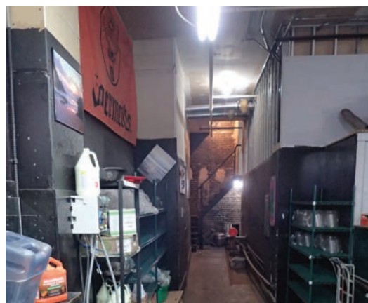
5 - Escalier qui mène aux espaces à bureaux
