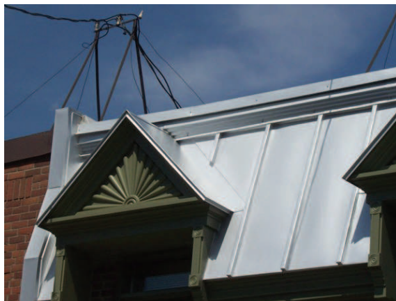
REPRISE DE LA TOITURE
