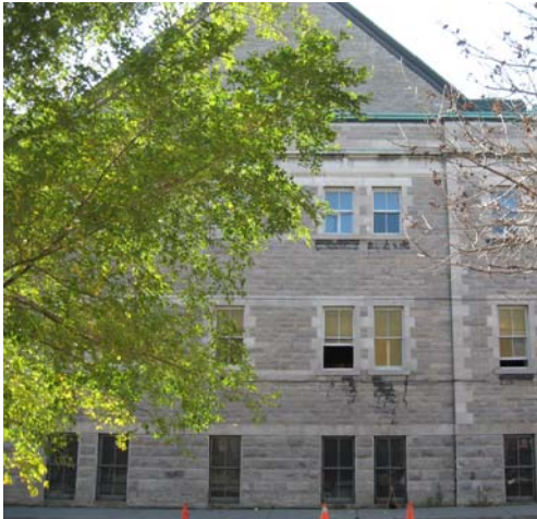
FAÇADE EN MAÇONNERIE : SACRISTIE DE L'ÉGLISE SAINTE-BRIGIDE, RUE CHAMPLAIN
