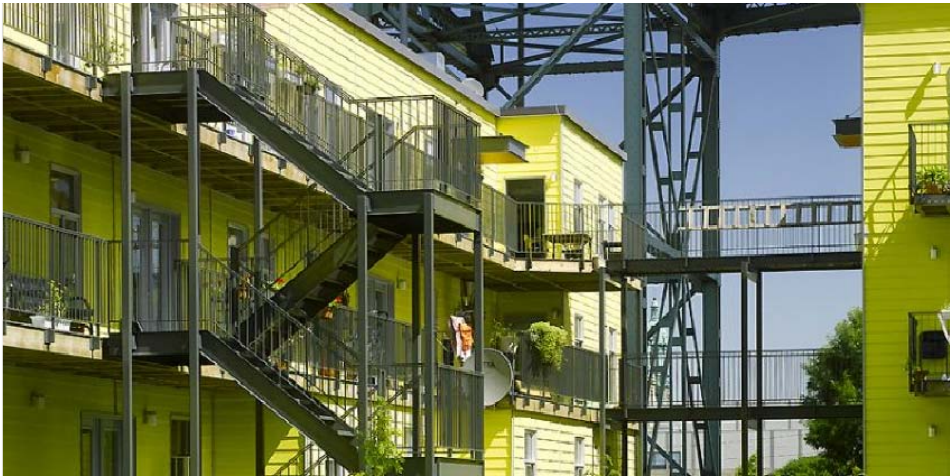
PAREMENT DE FIBRO-CIMENT : COOPÉRATIVE D'HABITATION AU-PIED-DU-COURANT, 2000 RUE TANSLEY
