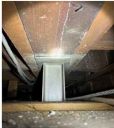
Colonne d'acier qui supporte la structure du plancher sans être rattachées mécaniquement
