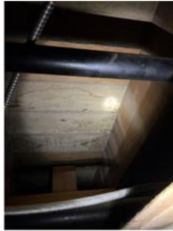
Signes d'infiltration d'eaux
