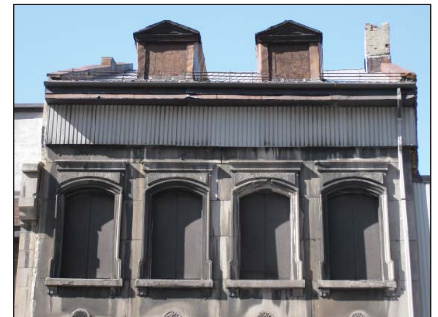
Détail de la corniche et des lucarnes
