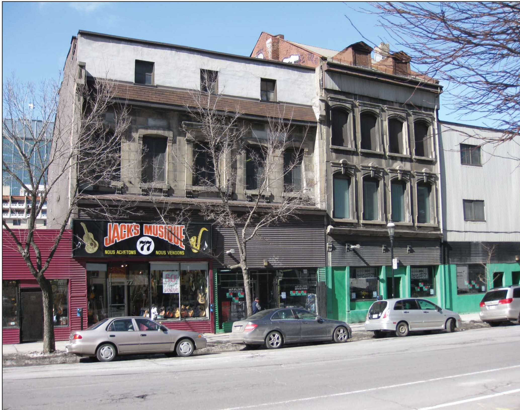
Façades en pierre du 77, 75 et 71 Saint-Antoine Ouest
