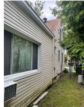
Façade latérale nord.
