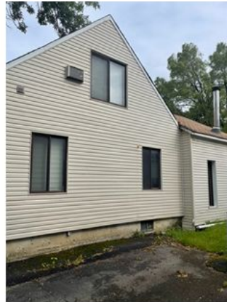
Façade latérale sud.
