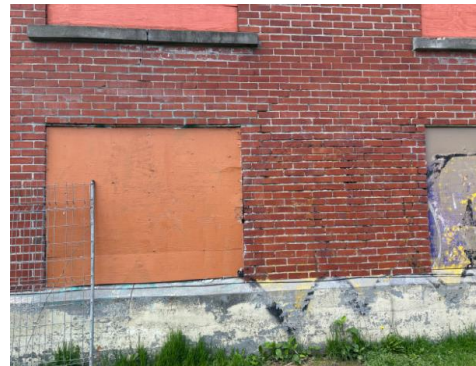
10-Joints de mortier partiellement et complètement évidés
