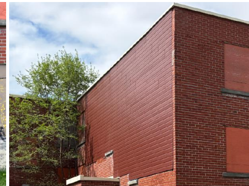
10-Joints de mortier partiellement et complètement évidés
