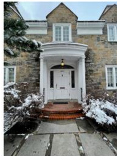
Porte d'entrée en bois massif, marquise et peron en briques en soldat conservé et restauré
