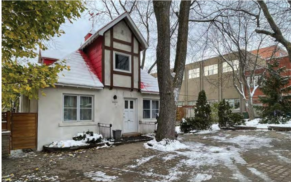
Dépendance à démolir
