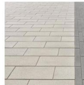
Surface en pavé de béton préfabriqué
